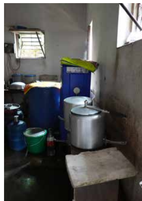
Auch die Küche müsste dringend renoviert werden. Zumindest sorgt ein Filter für sauberes Trinkwasser.
